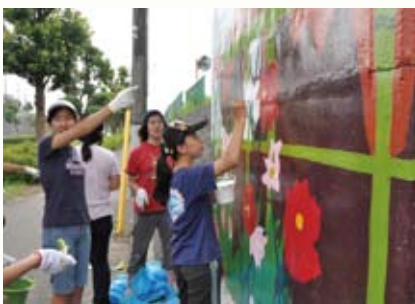
足場を取って最後の仕上げ
